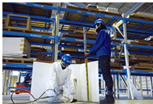
精度の高い技術により、ミリ単位で常時レベル確認をしながら施工をおこなう
