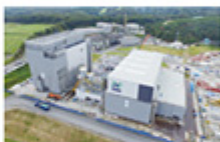
三木バイオマスファクトリー 現在(建設中)
