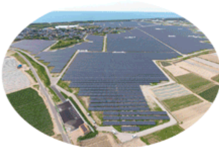
メガソーラー発電事業 (例：新潟県四ツ郷屋発電所)
