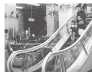
1956年 都市の賑の道となったエスカレーター
