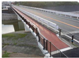
交通安全対策工事
