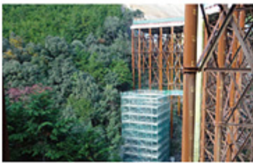
橋梁下部工事
