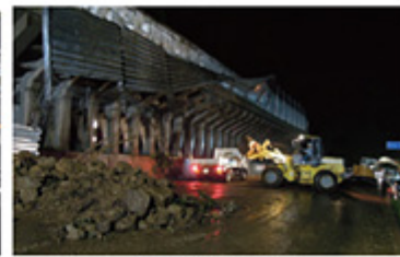
国道維持管理工事
