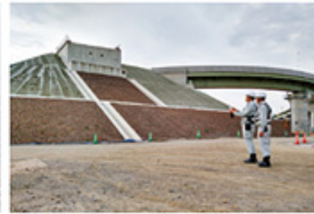
発注者支援業務・現場完成確認
