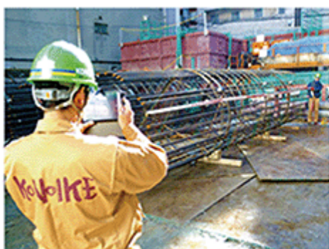
杭施工記録の様子
