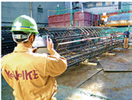
杭施工記録の様子
