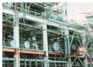
プラント(鉄架構)の耐火被覆
