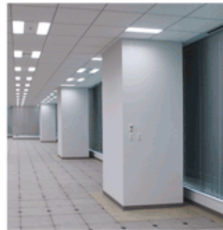
柱の耐火被覆 (事務所)
