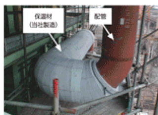
保温材取り付け (施工中)
