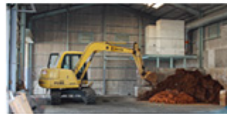
コンクリート固化
