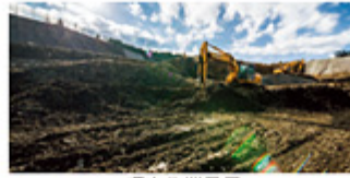
埋立作業風景
