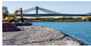
埋立作業風景
