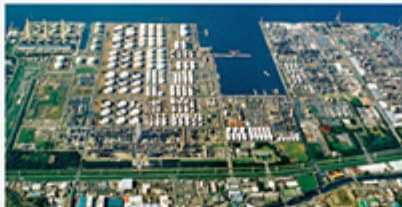
【製油所】 全国に3製油所を配置し安定供給
