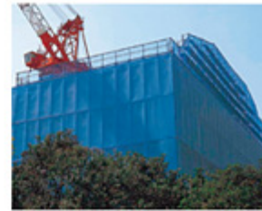
工事中シート
