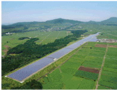
事業投資事業部門 環境エネルギー関連事業 メガソーラー発電事業（鹿児島県枕崎市）
