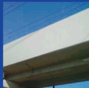
橋桁・橋脚・橋台等
