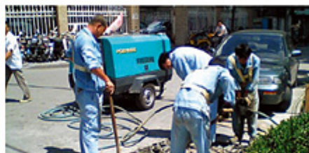
● 土木建設現場 ●
