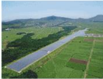
事業投資事業部門 国産エネルギー関連事業 メガソーラー発電事業（鹿児島県枕崎町）
