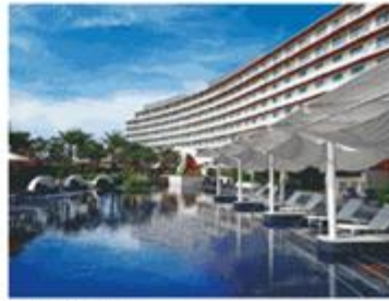
不動産事業部門 施設運営事業「ヒルトン沖縄北谷リゾート」
