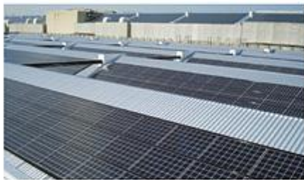
工場の操業を止めない屋根改修「WKカバー工法」
