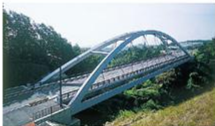
鋼製橋梁の製造・架設
