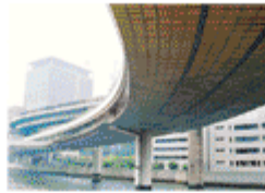
吊り足場(セーフティSKJ(ネル))
