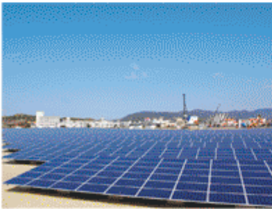
事業投資事業部門 環境エネルギー関連事業 メガソーラー発電事業（兵庫県淡路市）
