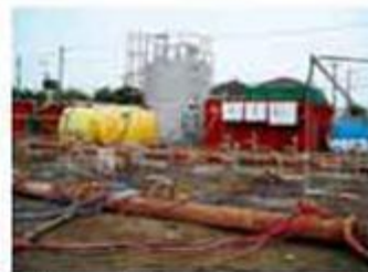
フルアップポイント工法
