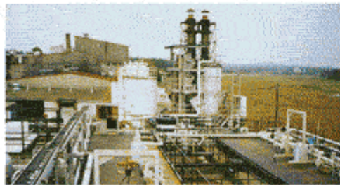
産業排水処理施設
