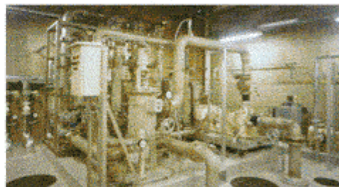
中水道システム（膜分離方式）
