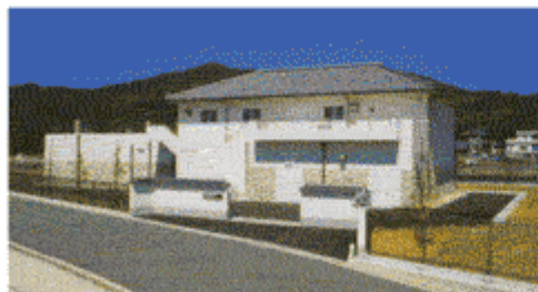
漁業集落排水処理施設
