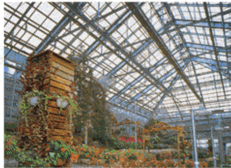
観光用温室施工例
