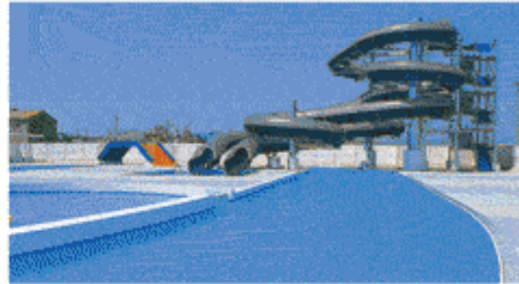
プール施工例
