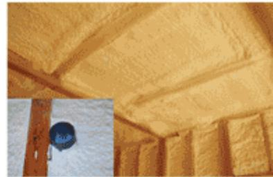
断熱材が隙間なく充填された様子
