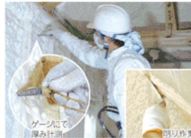
断熱に必要な適切な厚みの測定
