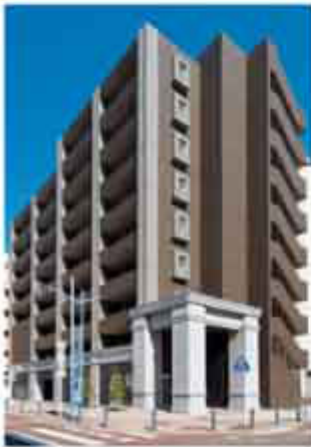
ガーラ・ステーション横浜南車道
