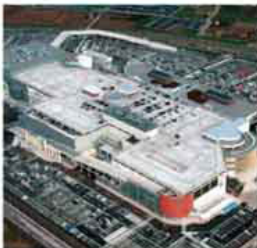
IBS「イアース」つくば (茨城県) 平成20年竣工
