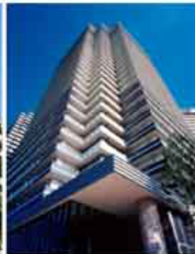
パシフィック ロイヤルコート みなとみらいアーバンタワー (神奈川県) 平成20年竣工
