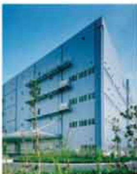
Oプロジェクト茨城 (千葉県) 平成19年竣工
