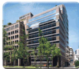
WAKITA藤村御堂筋ビル
