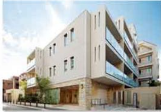
マンションの施工事例
