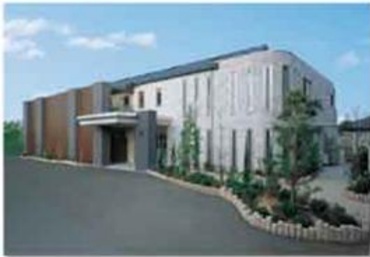
賃貸福祉住宅（グループホーム）の施工事例
