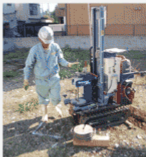
外注先による半自動式の地盤調査
