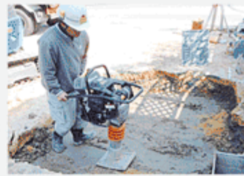
外注先による部分転圧工事例
