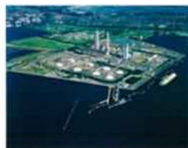
富津火力発電所
